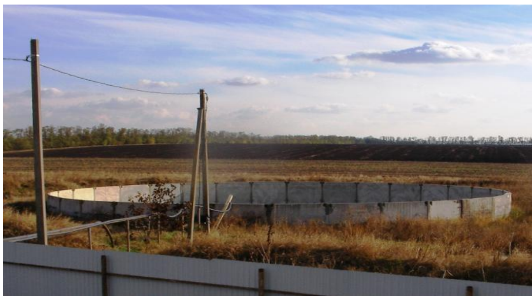
Рисунок 3.15 – Бетонный накопитель стоков
