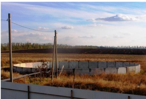
Рис. 8. Бетонный накопитель стоков
