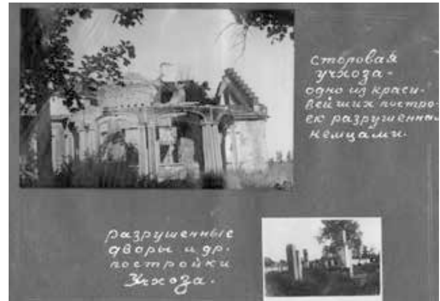
Ил. 1. Разрушенное здание столовой Учхоза и других построек. Из послевоенного альбома
